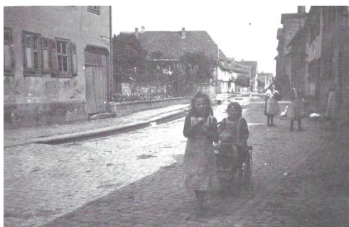
Die Bachstraße mit dem noch offenen Welzbach. Links, das Anwesen Bachstraße 23, war das Wohnhaus von Sophie Dornheimer. Das Haus wurde nach dem 2. Weltkrieg abgerissen.
